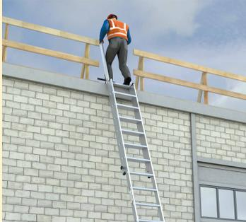
Stufen-Schiebeleitern ermöglichen durch mind. 8 cm breite Stufen mit einer Rutschhemmung von mind. R12 einen sicheren Auf- und Abstieg. Die Stufen gewährleisten zudem einen sicheren Stand zur Ausführung der Arbeiten.
