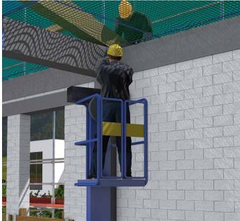
Kleinsthubarbeitsbühnen/Lifte stellen eine effiziente Alternative zu Leitern mit Standhöhen von bis zu circa 5 Meter dar. Sie sind für die Verwendung durch eine Person vorgesehen. Dank ihres geringen Gewichts können sie auf ebenem Boden energielos zum Einsatzort geschoben werden.
